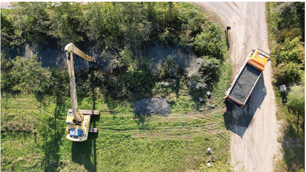
Durch Einsatz eines Long-Reach Baggers kann gezielt geräumt und der Eingriff in die Ufervegetation reduziert werden.
