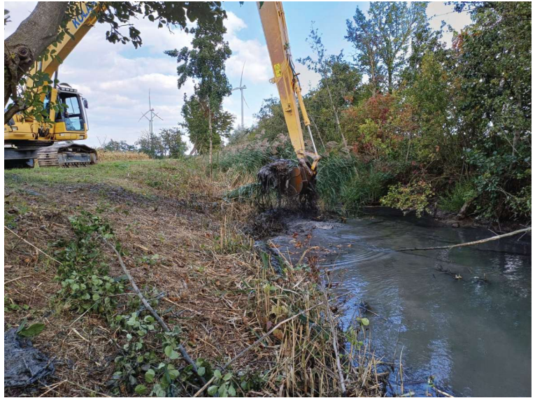
Schlammräumung am OSK um Durchfluss zu gewährleisten
