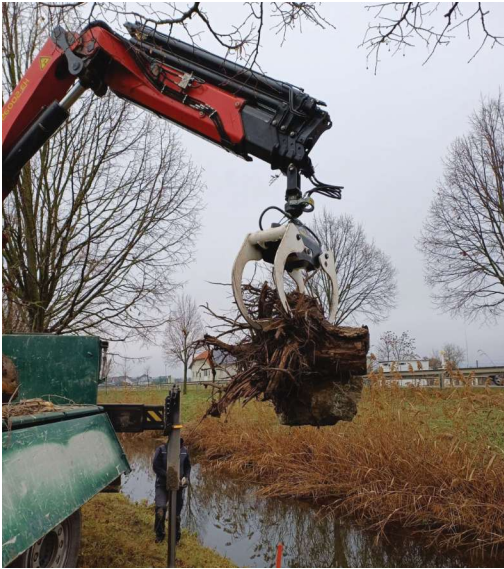
Einbau von Wurzelstockbunnen im Stempfelbach am OSK
